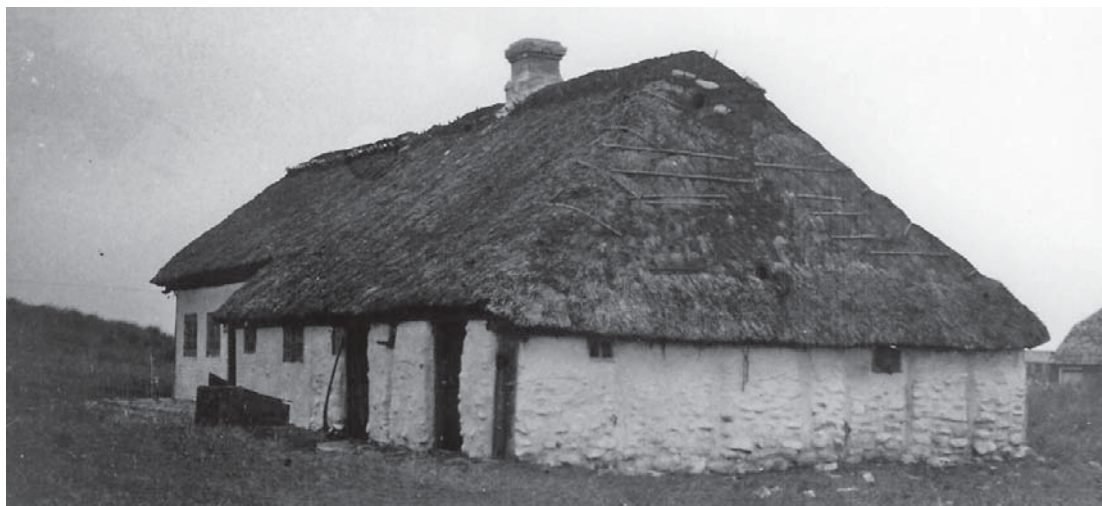
Maren Bolms hus i Agger, set fra øst. Her ses, hvordan der er brugt natursten som fyld mellem stolperne i ydervæggene. Huset er tækket med lyng, og der er lagt stave på for at holde det. Oppe ved møningen er desuden bundet en gammel kværnsten fast. Foto Dansk Folkemindesamling.
