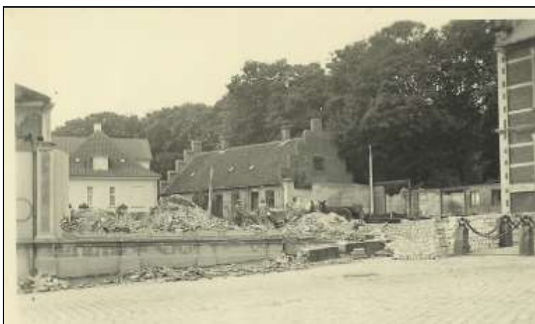
Figur 14. Brinkmanns gård under nedbrydning i 1937.
