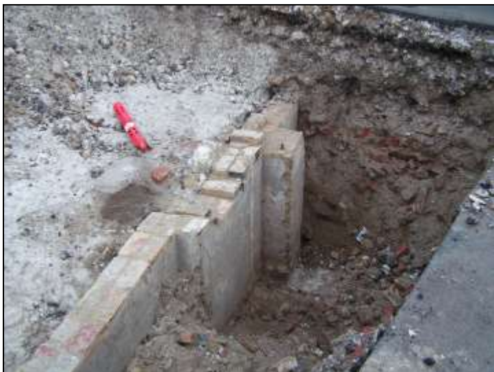
Figur 7. Kældermuren set fra sydøst. Murens inderside var dækket af puds. Ved bunden af muren var spor af et støbt gulv. I profilen over muren ses tydeligt skellet mellem undergrundskridt og opgravet fyld.
