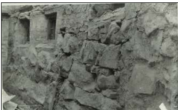
Figur 15. Gammelt murværk frilagt og fotograferet under nedrivningen af Brinkmanns ejendom. Blev ikke genfundet 2007.
